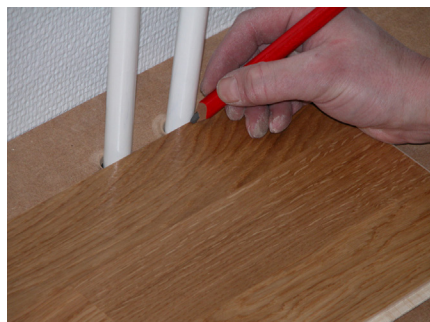
9: ...og hvor langt fra enden af brættet hullet skal være.
