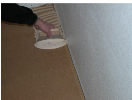
5: Fjern brædderne som du har lagt ud. Fordel lim på undergulvet hvor en hel række af brædder skal ligge. Læg brædderne ned en efter en op ad væggen. Sæt kiler mellem gulv og væg.
