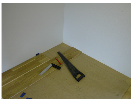
4: Tilskær brættet med en håndsav (fra toppen af brættet) eller en rundsav (fra undersiden).
