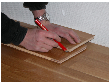
11: Den sidste række af brædder skal normalt skæres på langsiden. Med noten mod væggen, placer det sidste bræt ovenpå og kant mod kant med næstsidste bræt. Anbring et ekstra stykke bræt ovenpå og mål afstanden ved at trække bræststykket langs væggen og marker med en blyant hvor det sidste bræt skal skæres af.
