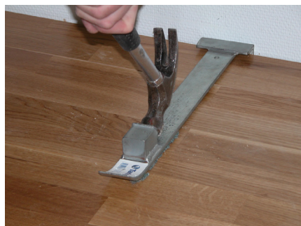
12: Læg lim og læg den sidste række af brædder og tryk dem på plads ved hjælp af Tarketts Tarktool.
