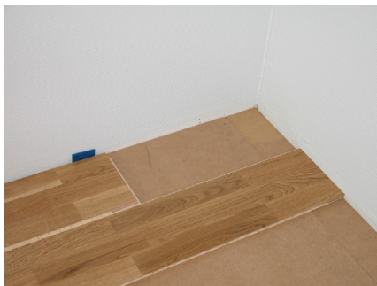
2: I slutningen af rækken, vend det sidste bræt så det ligger fer mod fer. Skub den korte ende tæt mod væggen.
