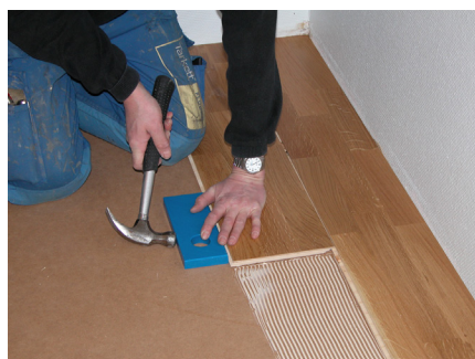
6: Gentag punkt 1-5, start med resten af brædderne skåret fra den forrige række.
