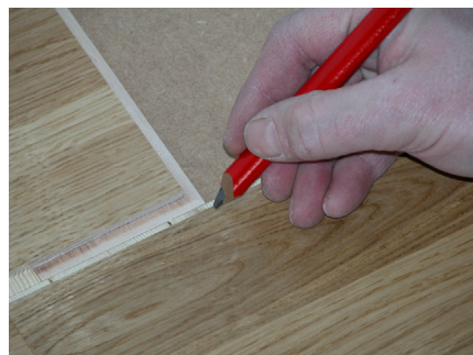
3: Marker med en blyant og skær 8-10 mm fra det sidste bræt for nemmere at få brættet på plads.
